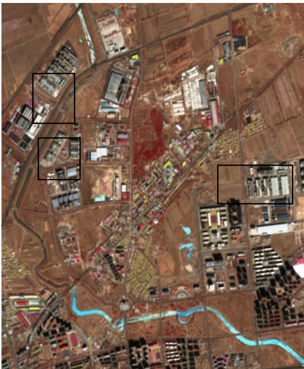
Vista aérea del clúster de centros de datos de Alibaba en Zhangbei, provincia de Hebei, China. Tres emplazamientos adyacentes desarrollados entre 2016 y 2025 forman parte de la estrategia china «Datos en el Este, Computación en el Oeste». Situado en el condado de Zhangbei, rico en energía eólica y solar, el clúster pone de relieve la huella territorial, la demanda de electricidad y las presiones de integración en la red asociadas a la computación de IA a gran escala. Fuentes de datos: Epoch AI; imágenes en falso color de Sentinel-2, febrero de 2026.
