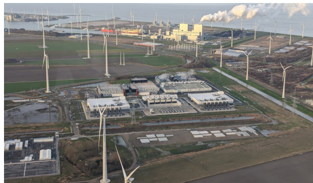
Vista aérea del centro de datos de Google en Eemshaven, Países Bajos, rodeado de aerogeneradores y una central eléctrica cercana. A medida que la IA se expande, los centros de datos como este requieren grandes cantidades de electricidad, lo que convierte el suministro energético en un reto clave. Foto de Wvdp (Wikimedia Commons).
