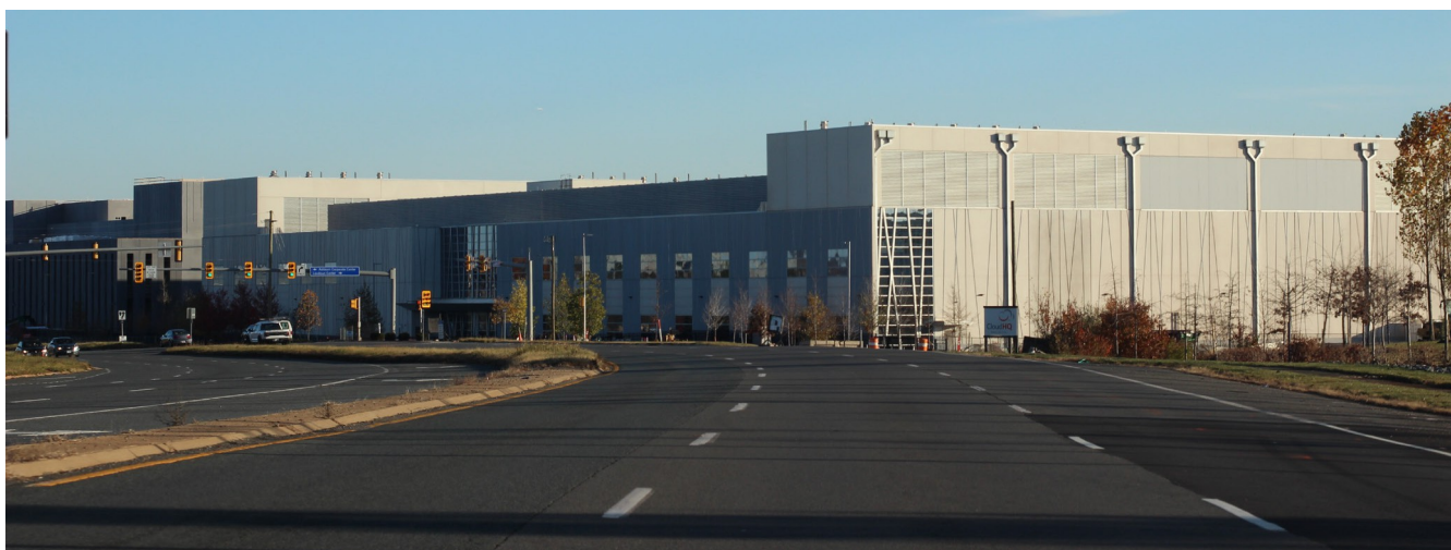
Centro de datos en Ashburn, Virginia (Estados Unidos). Esta zona, que alberga una de las mayores concentraciones de centros de datos del mundo, cuenta con densos grupos de instalaciones que dan servicio a la nube y a los servicios de IA a nivel mundial, lo que pone de relieve cómo la infraestructura digital se concentra en unas pocas regiones en medio de una brecha global cada vez mayor. Foto de Emily Richardson (Flickr).
